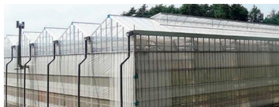
植物工場の温度管理をする薪ボイラーの燃料は造園業の廃棄木材による木質バイオマス等を使用
